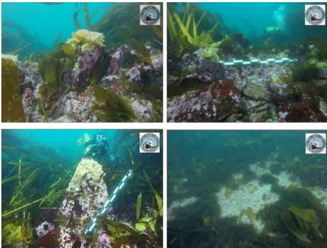
Figure 41 : Photos prises lors des plongées de la SAMM sur TAF1. Longueur de la mire : 1m. En haut à gauche : lames de granite en position redressée au sommet du mur. En bas à gauche : Grosse pierre verticale au sommet du mur. En haut à droite présence locale de gros blocs de granite vers le sommet. En bas à droite graviers recouverts d'algues à la base du mur. (Crédit photos SAMM)
