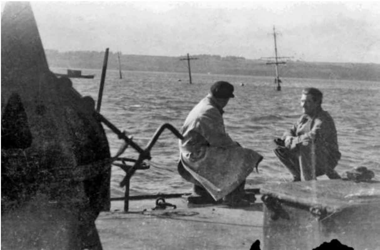
Gaston et son superviseur devant le chantier
