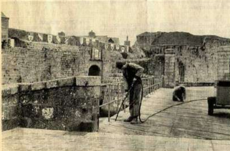
La réfection du pont d'entrée à la Ville-Close a débuté hier matin...
